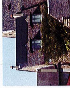
Panneaux photovoltaïques adaptés aux toitures en ardoise (Vigeois, 19) : structure photovoltaïque noir non réfléchissante et cadre noir.
